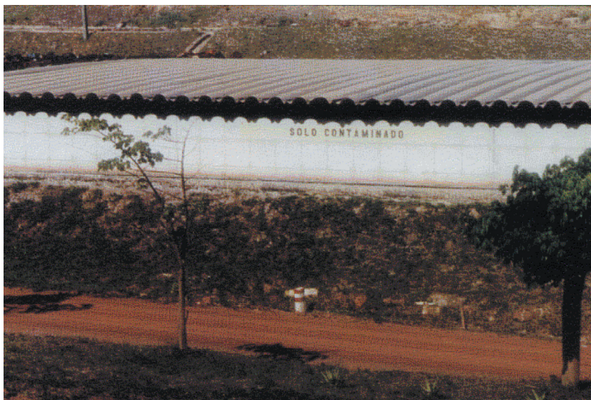
Figura 9: Exemplo de remediação de solo ex situ , em que o solo contaminado é transferido para outro local, onde será feito o tratamento (Fonte: Silvestre e Marchi, 2003).
