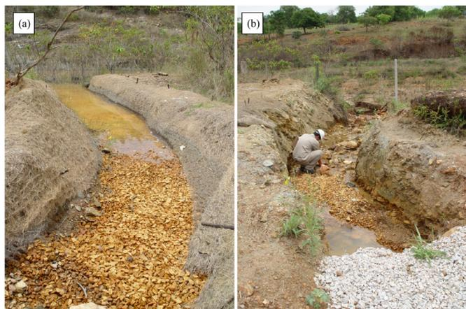
Figura 2: Brita de calcário recoberta por óxidos de Fe (a) e renovação da brita (b) em drenos alcalinos (tratamento passivo da drenagem ácida) (Fotos: Luiz E. Dias).
