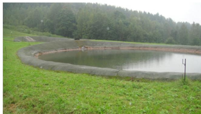
Figura 4: Sistema anaeróbico de *wetlands* construído com plantio profundo e utilizado para tratamento da DAM na região de Pöhla (Alemanha) (Foto: Ana Claudia Queiroz Ladeira).
