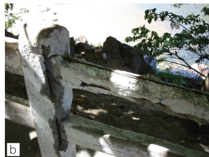
Figura 3: Corrosão química em concreto armado: (a) poste; (b) mureta (Boia Viagem, Niterói - RJ).
