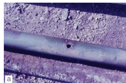
Figura 3: Corrosão química em concreto armado: (a) poste; (b) mureta (Boia Viagem, Niterói - RJ).
