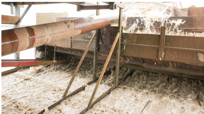
Figura 4: Água passando pelo gradeamento (parte superior) e escorrendo pela caixa com os carpetes (parte inferior).
