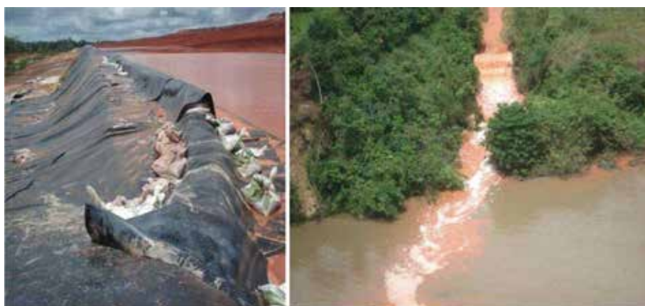
Figura 1: Detalhes do local de transbordo da bacia de rejeito da empresa ALUNORTE e o ponto de lançamento no rio Murucupi (Belém, PA). Fonte: Brasil, 2010.
